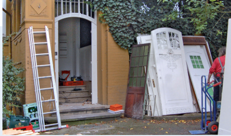
Sorgfältiger Ausbau von wertvollen Bauteilen
