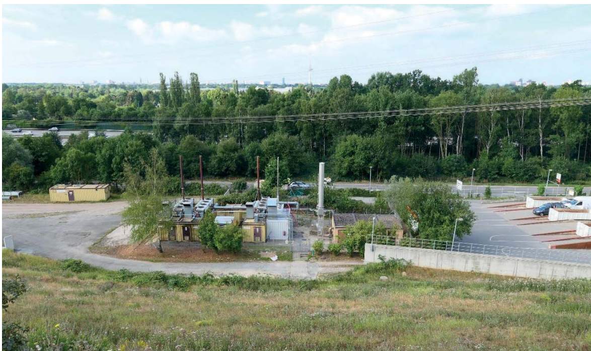
Abbildung 6 Die neue Anlage in Lichtgrau inmitten der Bestandsanlage
