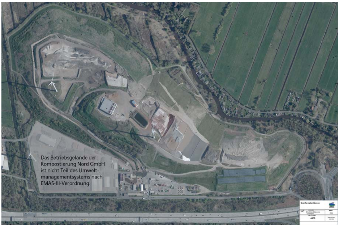
Abbildung 5 Luftaufnahme der Blocklanddeponie Bremen von 2015
