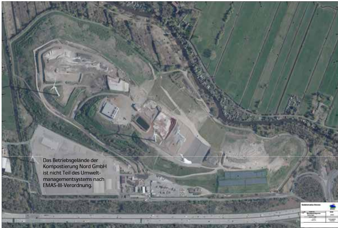
Abbildung 14 Luftaufnahme der Blocklanddeponie Bremen von 2015
