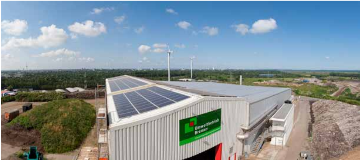
Abbildung 9 Photovoltaik-Dachanlagen, © fotoetage bremen/Tristan Vankann
