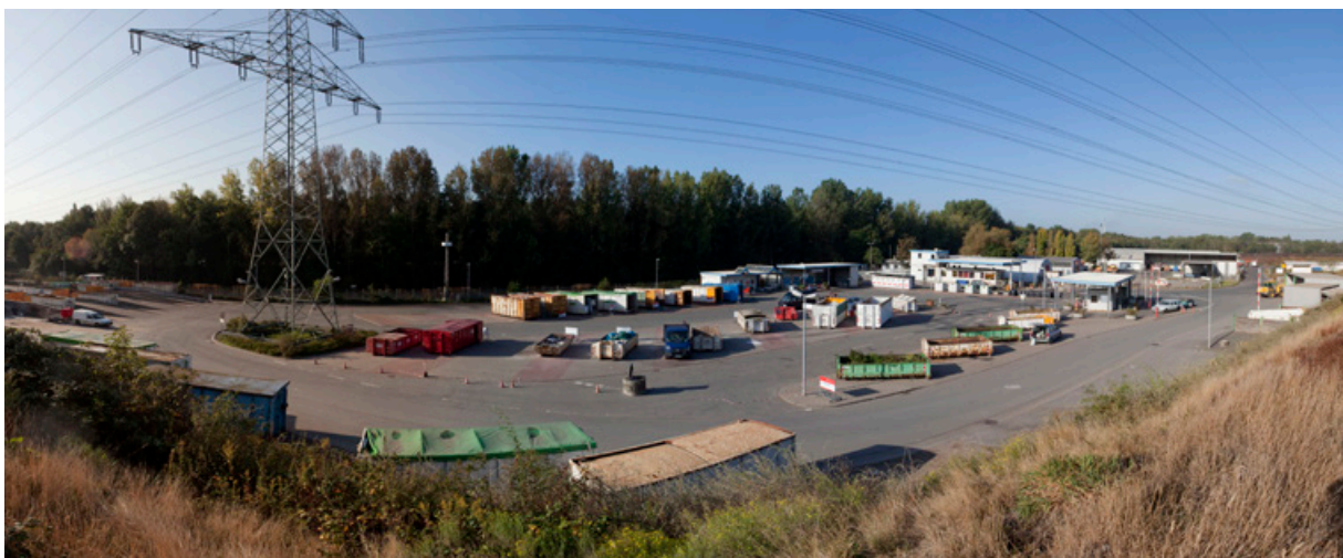
Abbildung 8 (oben links): Photovoltaik-Dachanlagen Abbildung 9 (oben rechts): Photovoltaik-Freiflächenanlage Abbildung 10: Recycling-Station Blockland © Abbildungen: fotoetage bremen/Tristan Vankann
